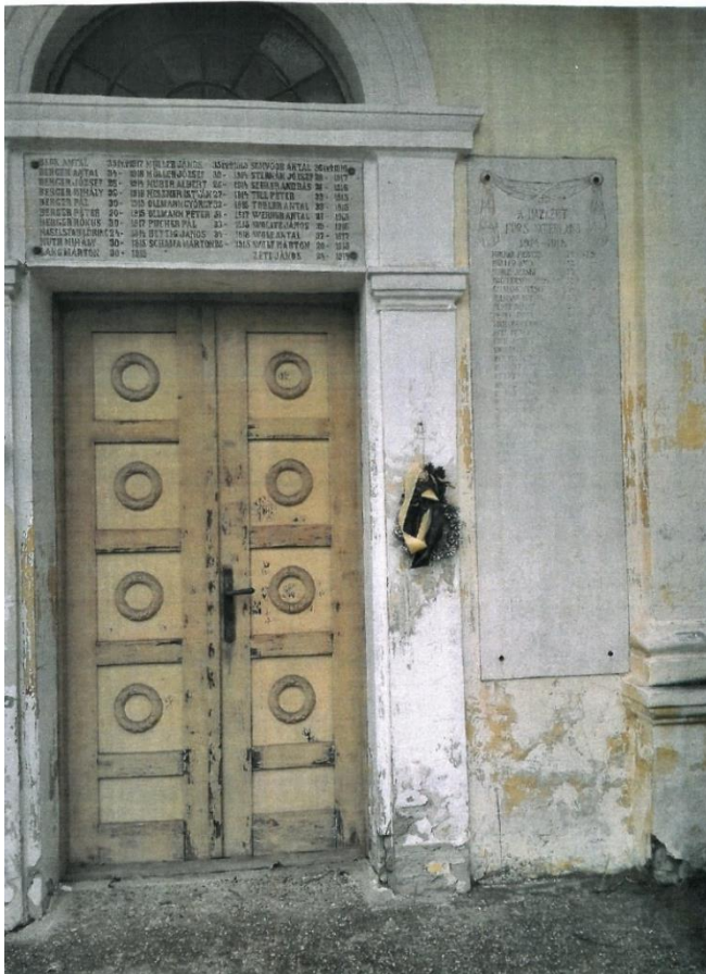
Die Kapelle vor der Erneuerung
