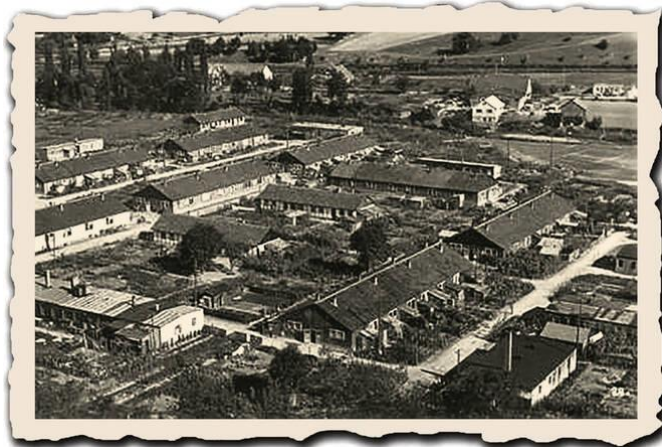
In den Baracken des Auffanglagers Neckarzimmern hausten mehr als tausende Flüchtlinge unter schwierigsten Umständen. Foto: privat
